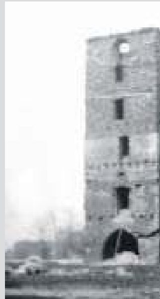
W trakcie rozbiórki ruin zamku
