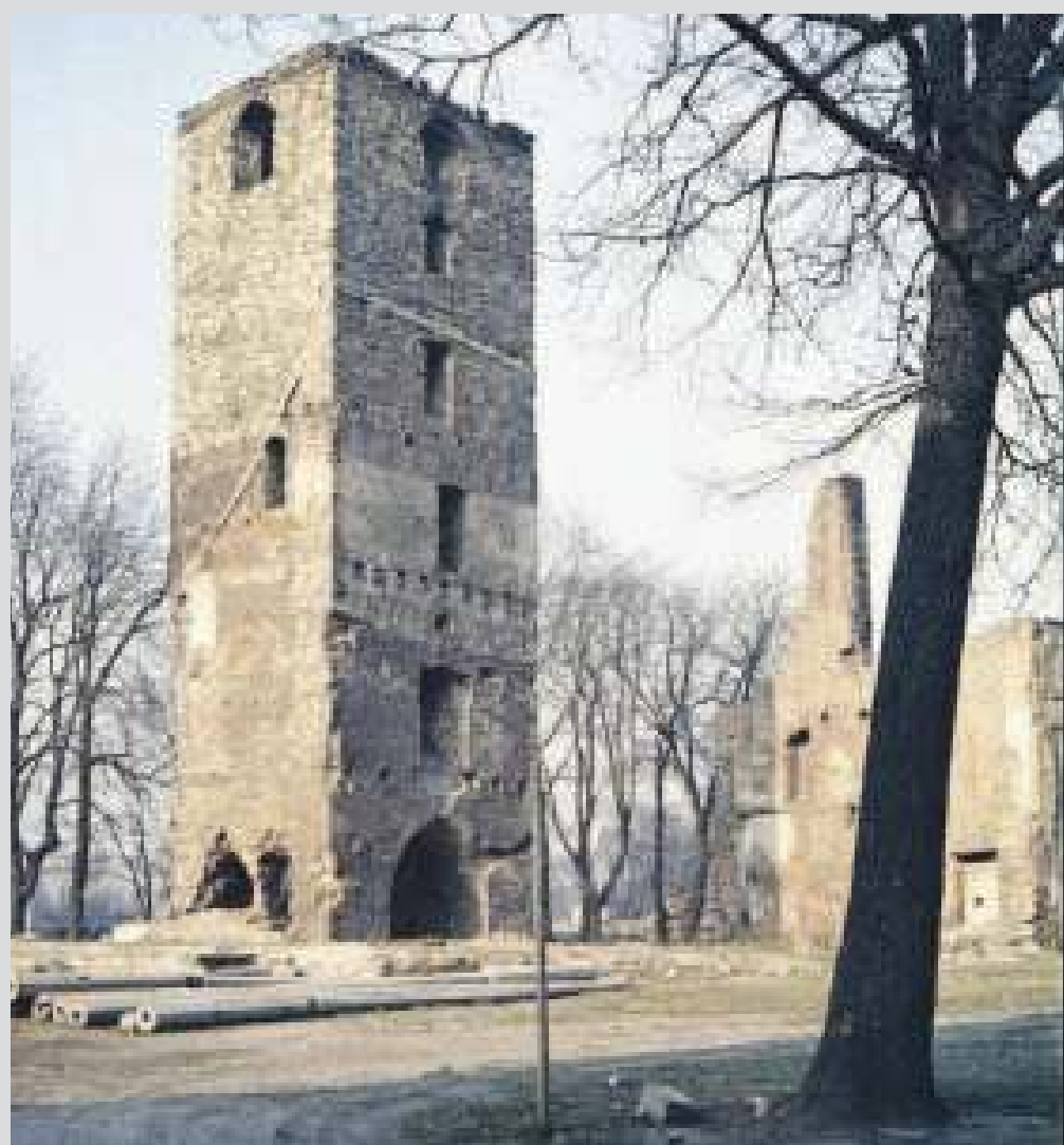
Widać „podcięcie” wieży
