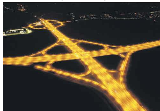
Obwodnica Olsztyna w ciągu S51
