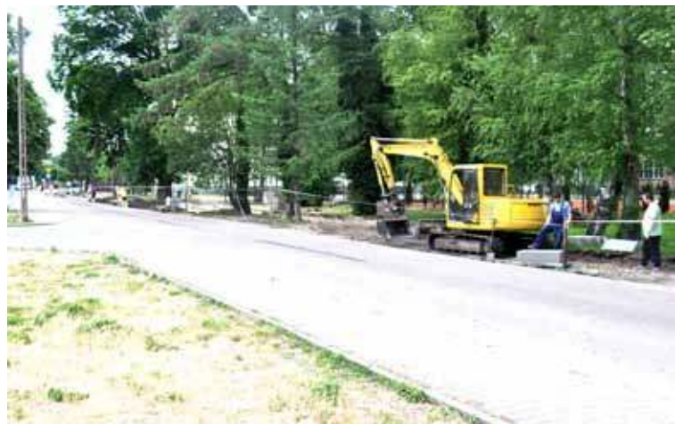
Trwa budowa ścieżki rowerowej i chodnika przy ul. Dworcowej w Stepnicy..
