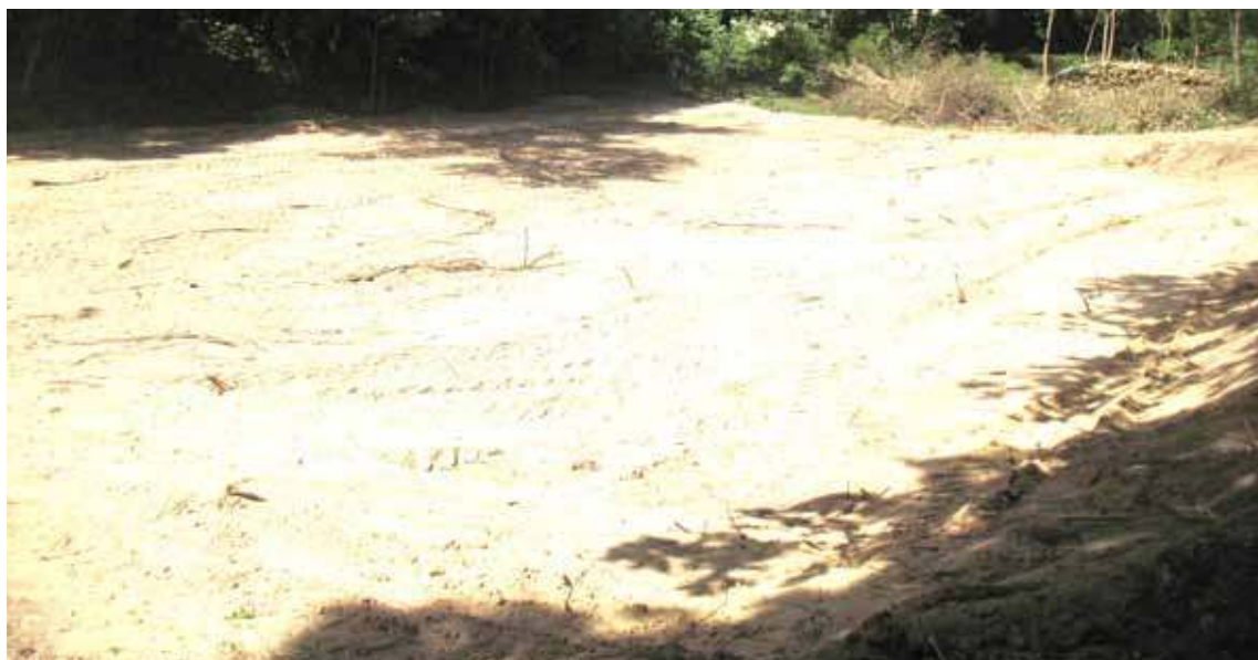
Teren jest już oczyszczony oraz wyznaczono zarys boiska
