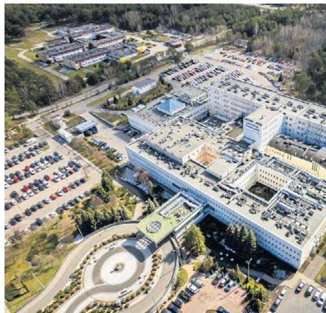
Na terenie bydgoskiego CO powstanie nowy pięciokondygnacyjny budynek. Koszt inwestycji wynosi pół mld. zł
