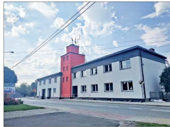
Remiza OSP Radlin II po remoncie. Zmieniła się nie tylko nowoczesna elewacja, ale także ocieplenie budynku.
