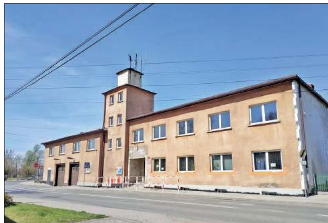
Remiza OSP Radlin II przed remontem
