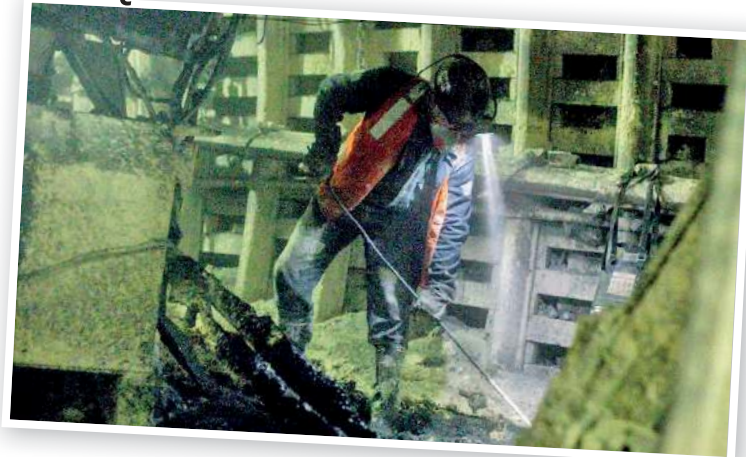
Kopalnia KWK ROW Ruch Marcel rozpoczyna eksploatację kolejnej ściany pod Markłowicami. Fedrowana będzie do końca września przyszłego roku.
