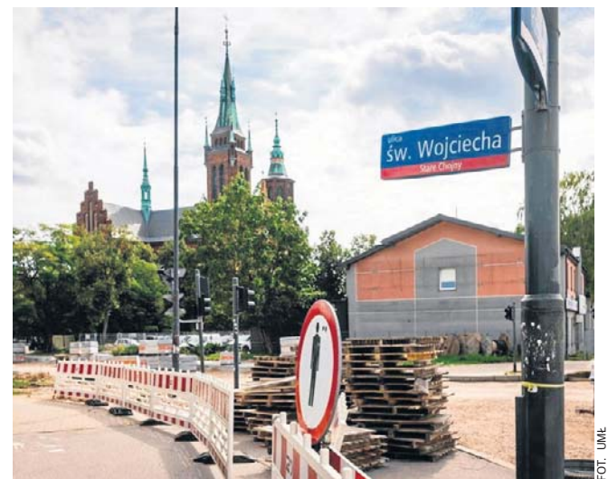
Trwa remont ulicy św. Wojciecha.
