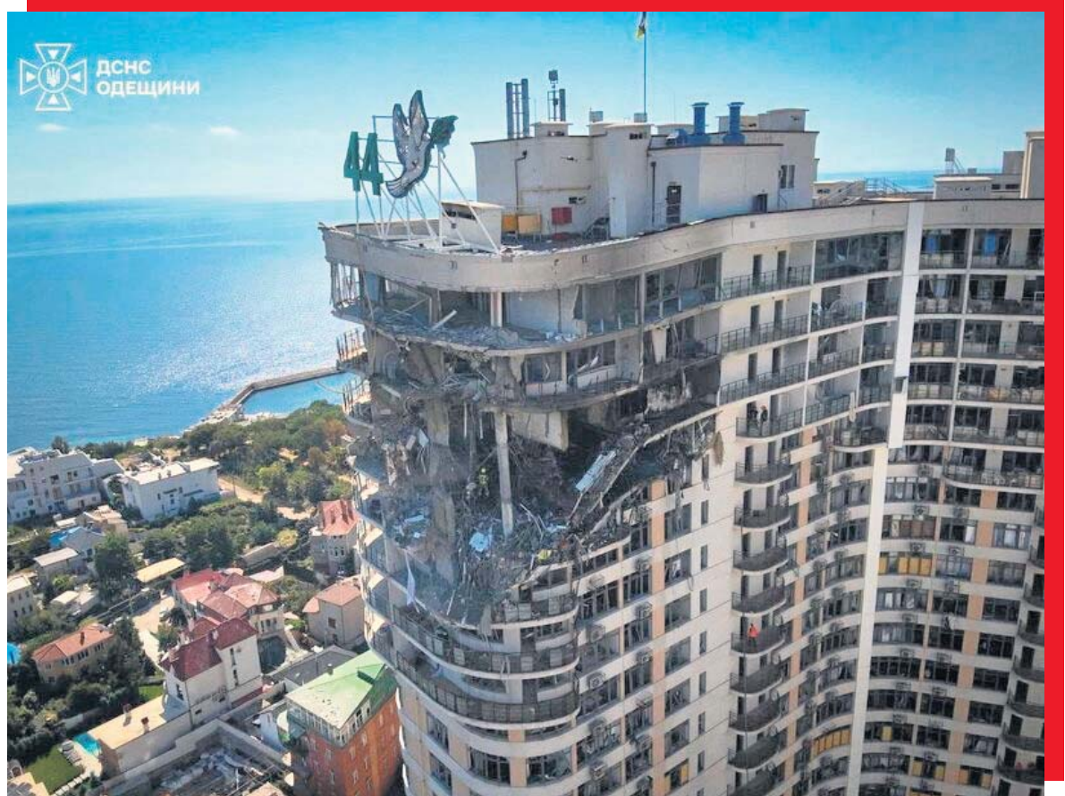
Rosjanie atakowali Odessę w nocy z soboty na niedzielę. Uszkodzono m.in. placówkę edukacyjną i wielopiętrowy budynek,
