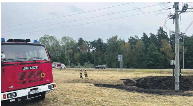
Trawa spłonęła pod słupem energetycznym w Korzeńsku
