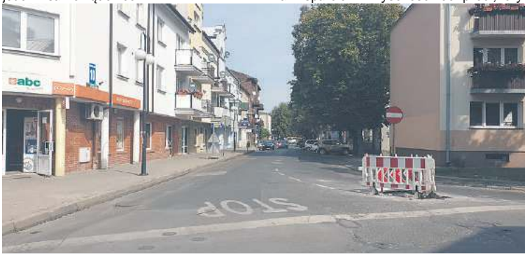
Ulica Dreszera w Chełmie wymaga pilnej przebudowy
