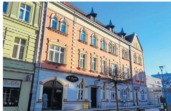
Czy kolejny przetarg wyłoni nowego właściciela budynku przy Bartoszewskiego? Przekonamy się 11 grudnia
