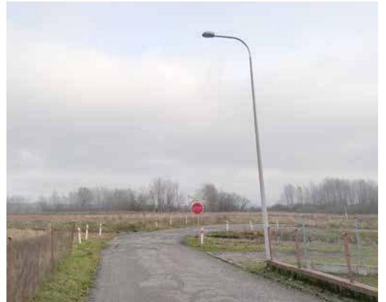
O ile widoczna na zdjęciu lampa działa poprawnie, to sam przejazd nie jest wcale oświetlony
