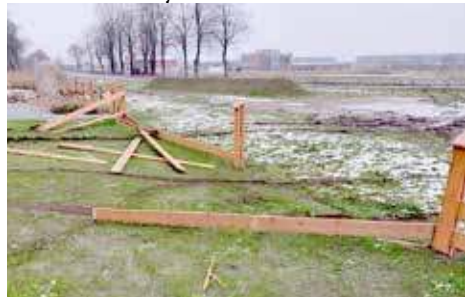
Zniszczenie ogrodzenia kościoła w Wojcieszynie nastąpiło z soboty na niedzielę
