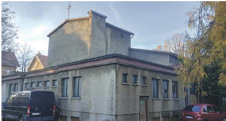
Dawny kościół zostanie wyburzony
