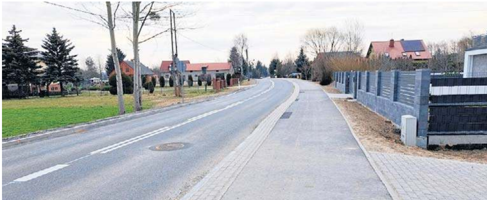
Ścieżka rowerowa w Nowej Wsi - po niemal trzech latach udało się ją w końcu zbudować
