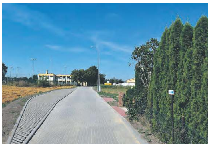
Ul. Pocztowa w Pruszczu.
