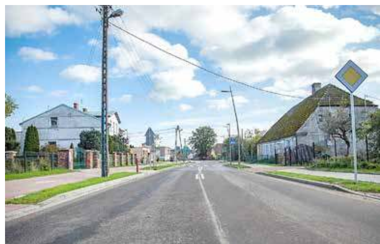
Nowa jezdnia, chodniki, ścieżka rowerowa, droga wybudowana została według najwyższych standardów
