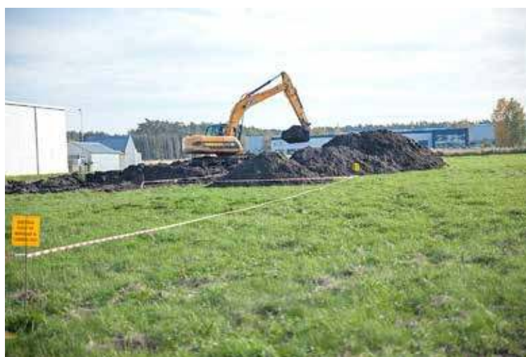
Rozpoczęły się także prace ziemne przy zakładzie Faraone- firma rozbudowuje halę
