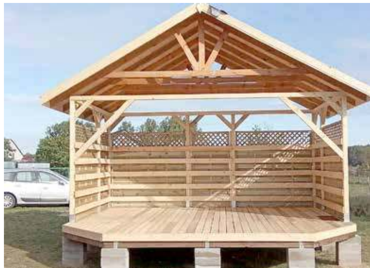
Lekka konstrukcja mini-amfiteatru w zupełności wystarczy na organizację miejscowych wydarzeń kulturalnych. Fot. Gmina Przybiernów
