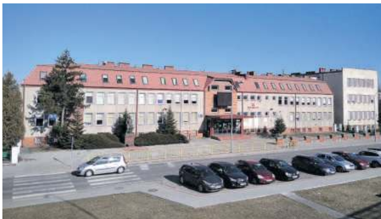
Budowlanka przejdzie termomodernizację
