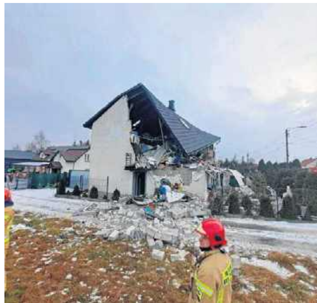
Do wybuchu butli gazowej doszło w niedzielny poranek w domu jednorodzinnym w miejscowości Brzezinki
