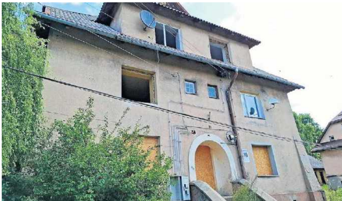
Budynek przy ulicy Robotniczej 10 w Starachowicach zostanie wyremontowany.
