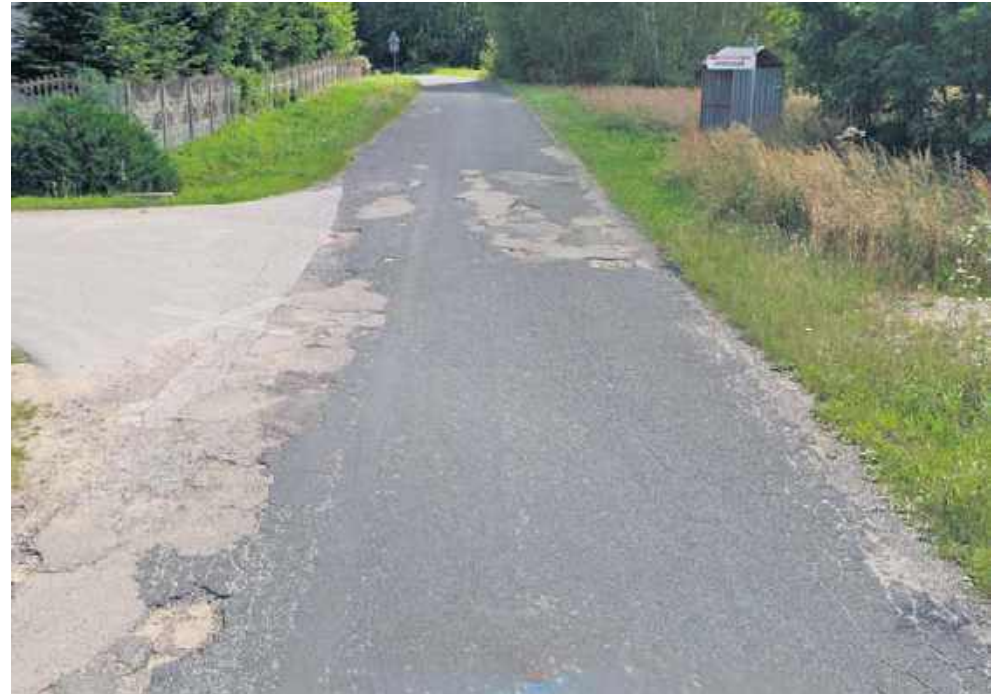
Aktualny stan drogi
