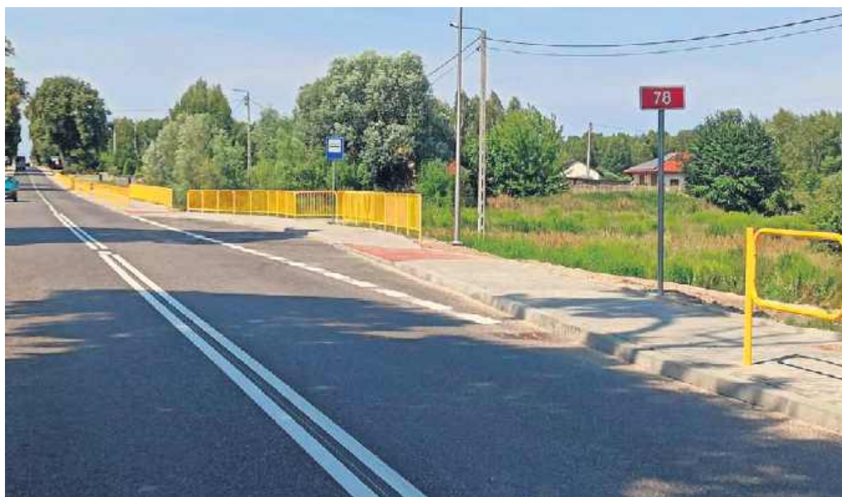
Plany te obejmują modernizację drogi na łączną długość 25 kilometrów w okolicach Nagłowic.
