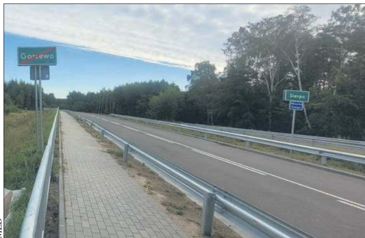
Trzykilometrowy odcinek obwodnicy Sierpca to kluczowa i największa inwestycja drogowa zrealizowana w tym rejonie. Jej koszt to kwota ponad 91 milionów zł
