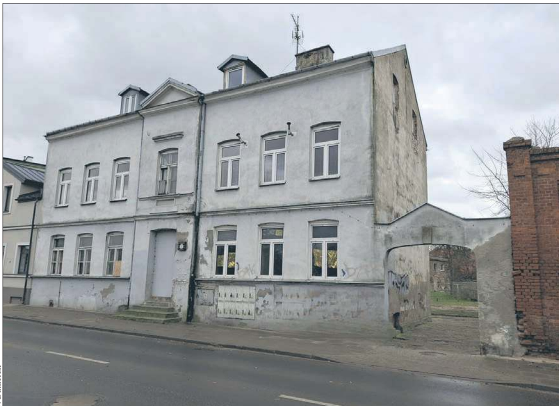
Kamienica przy ul. Nowowiejskiego 11
