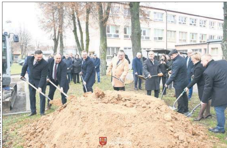
Budowa zadaszzonego boiska wielofunkcyjnego przy ZS nr 2 ma być ukończona w ciągu ośmiu miesięcy. Symboliczne wbicie pierwszej łopaty pod budowę odbyło się 6 grudnia 2024 roku
