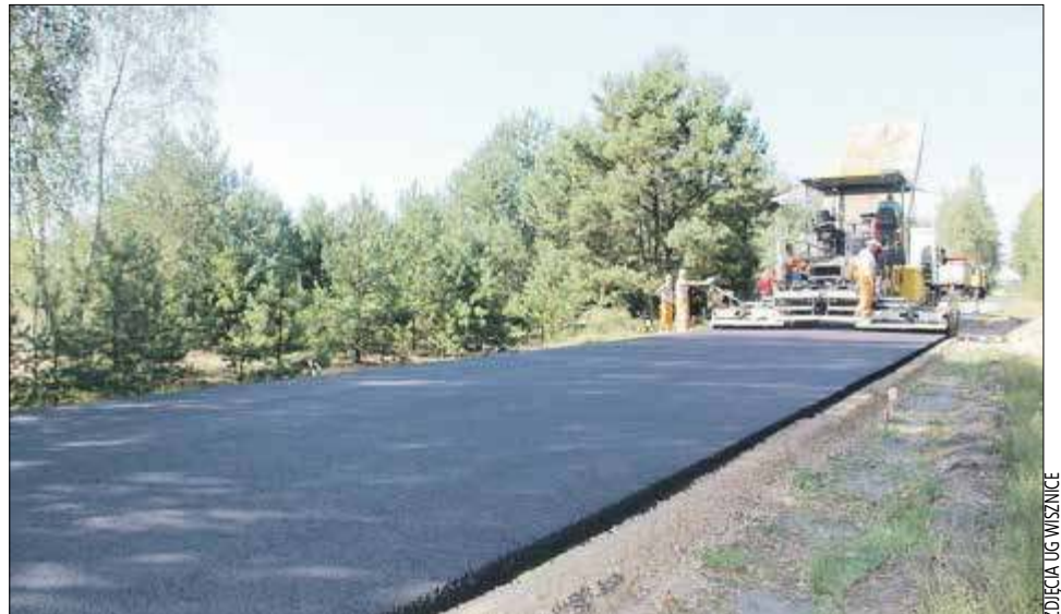
Gmina inwestuje w infrastrukturę drogową. Przykładem jest droga gminna w Rowinach zmodernizowana z Funduszu Dróg Samorządowych
