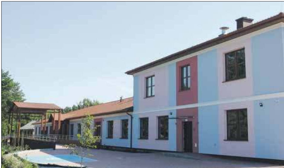
Najważniejszą inwestycją w ramach rewitalizacji gminy Wisznice jest utworzenie Zakładu Opiekuńczo-Leczniczego w Curyń
