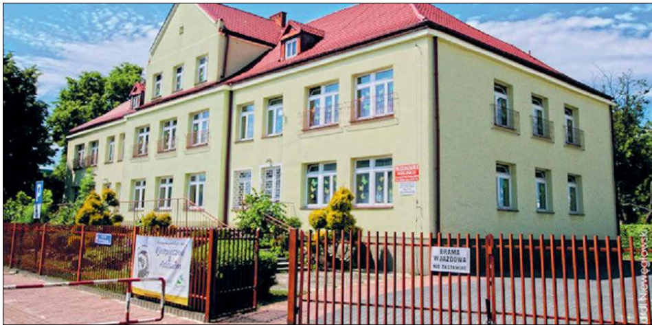
Dzięki unijnym funduszom budynki przedszkoli miejskich przejdą modernizację, która pozwoli na ich bezpieczne użytkowanie
