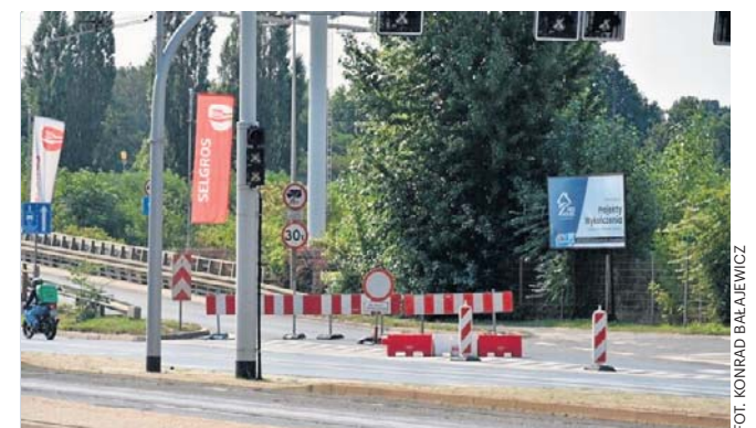
W sobotę zniknęły widoczne na zdjęciu barierki
