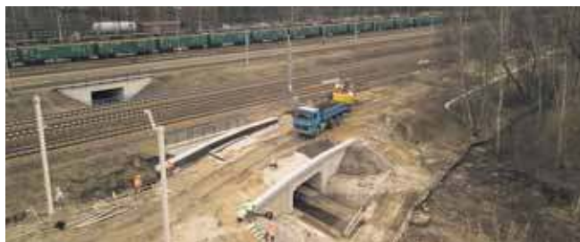
Prace przy budowie linii kolejowej do lotniska nabierają tempa
