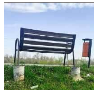
Z betonowych walców nie zdarto nawet szpecącego papieru.
