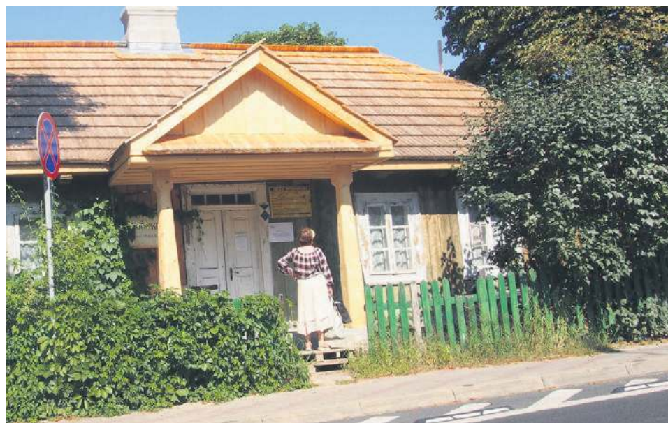
Wymiana i rekonstrukcja dachu kosztowały 90 tys. zł.
