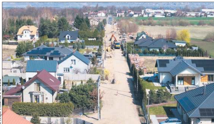
Trwa przebudowa ulicy Browarnej
