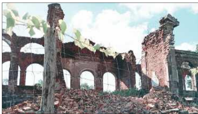
■ Budowla uległa zniszczeniu w dużej mierze wskutek niekorzystnych warunków pogodowych FOT. FUNDACJA GNIAZDO/ FB
