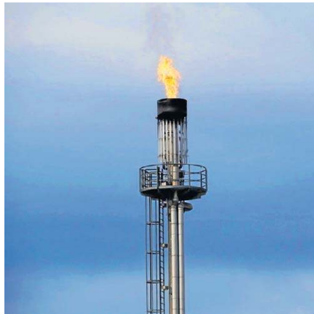
Nowa tłocznia zwiększy przepustowość sieci, co zmniejszy ryzyko zakłóceń, szczególnie zimą (zdj. ilustracyjne)
