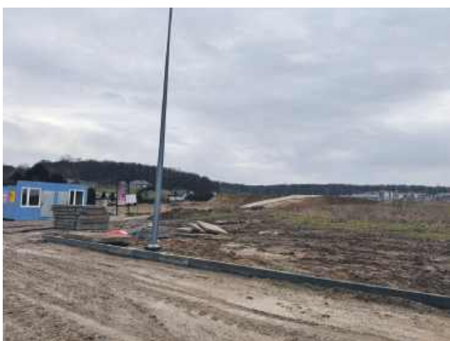
Tak wygląda plac budowy...
