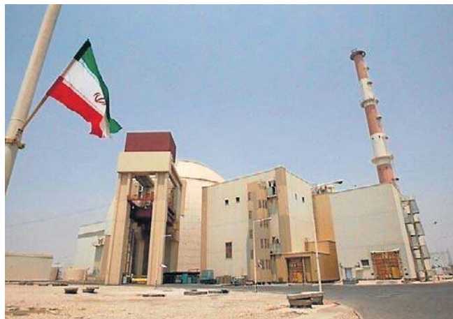
Buszehr to kluczowa irańska elektrownia jądrowa. Została uszkodzona po ataku raketowym
