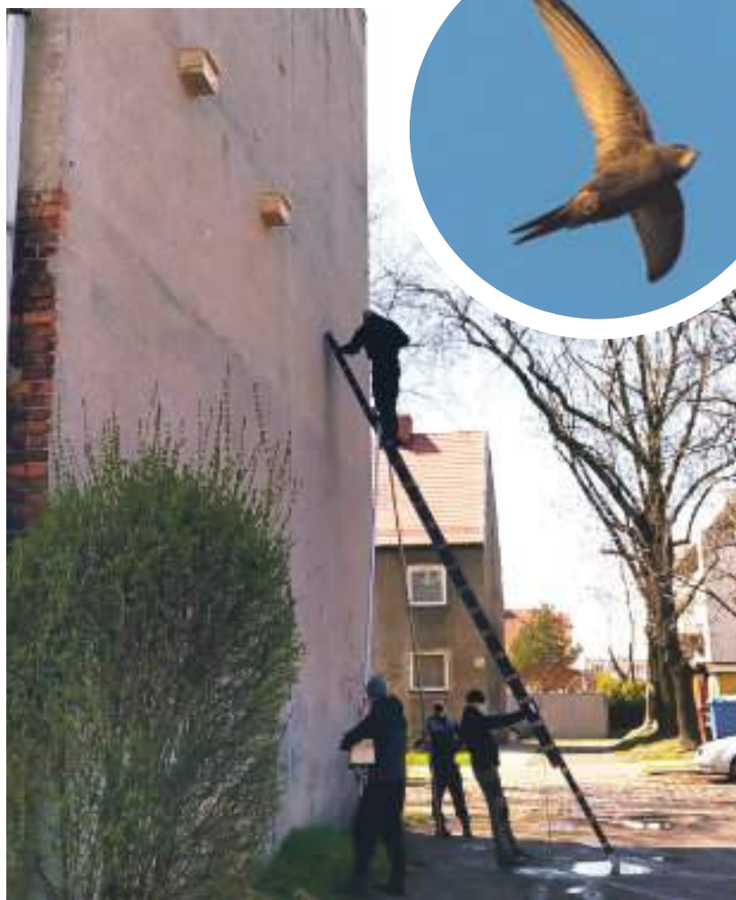
► Montaż domków dla jerzyków na elewacjach budynków ZBM-TBS Fot. ZBM-TBS
