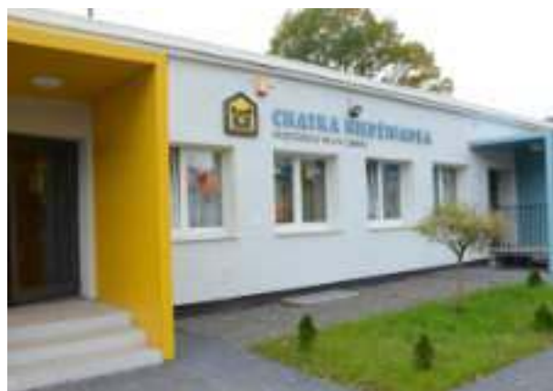
► Jedno z wyremontowanych przedszkoli Fot. Igor Cieślicki
