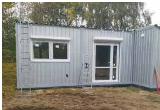
Niedawno zakończono budowę świetlicy kontenerowej w Pawłótku
