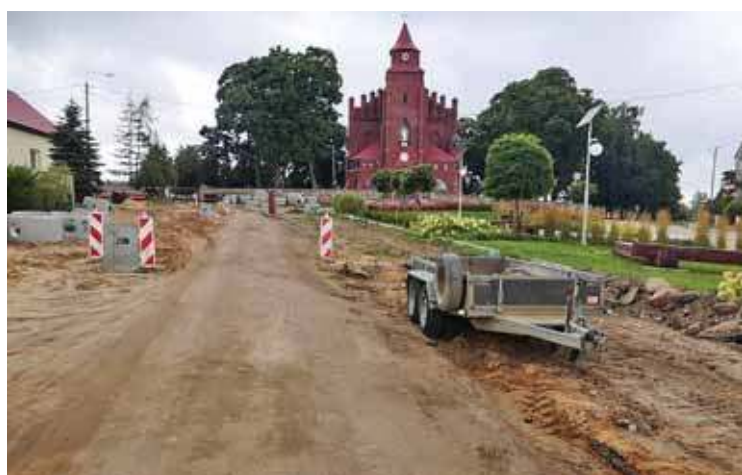
Polski Ład nie jest jedynym źródłem dofinansowywania inwestycji samorządowych. Na zdjęciu: przebudowa fragmentu drogi powiatowej w Wyszynach Kościelnych. Wartość: 5 mln zł, 3/4 tej kwoty stanowi dotacja z budżetu województwa mazowieckiego
