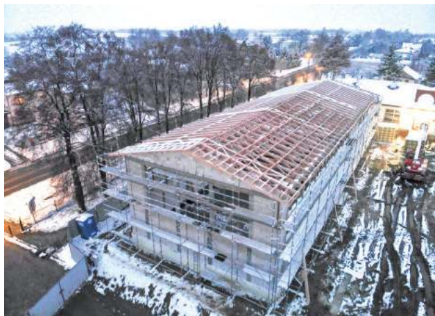
W SP im. Twórców Ludowych Lubelszczyzny w Rudce Kozłowieckiej powstaje nowa sala gimnastyczna i trzy dodatkowe pomieszczenia dydaktyczne
