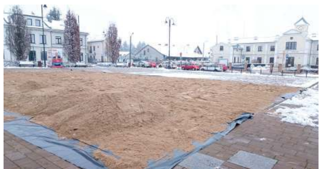
Zarys lodowiska jest już widoczny dzięki wyłożonemu na rynku piachu stnowiącego podbudowę dla instalacji obiektu
