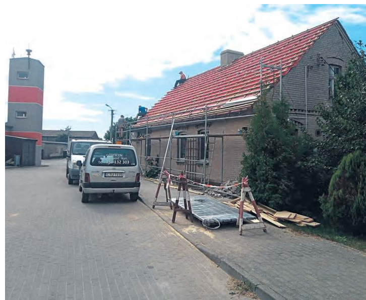
Dach wymieniono na jednym z budynków w Wielkim Mędomierzu.
