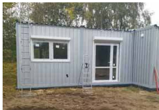
Niedawno zakończono budowę świetlicy kontenerowej w PawłóWKu
