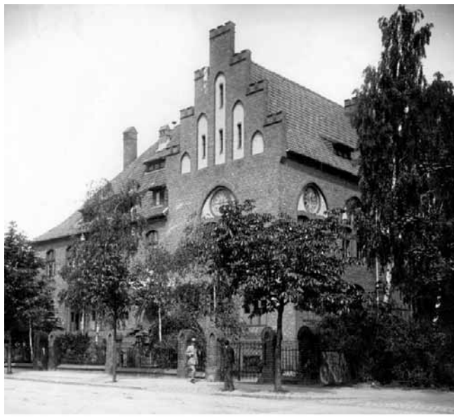
Budynek preparandy katolickiej, dziś gmach szkoły V LO
