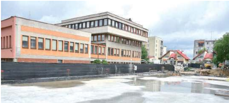
Budowa hali sportowej RCEZ w Biłgoraju
