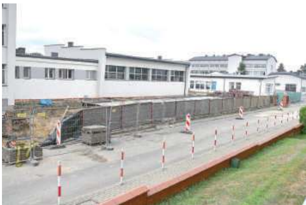
Budowa hali sportowej RCEZ w Biłgoraju
