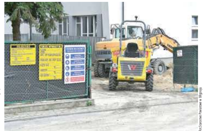
Budowa hali sportowej RCEZ w Biłgoraju
