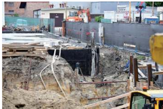
Budowa hali sportowej RCEZ w Biłgoraju
