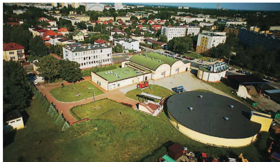
Tak z lotu ptaka wygląda Stacja Uzdatniania Wody w Stalowej Woli
