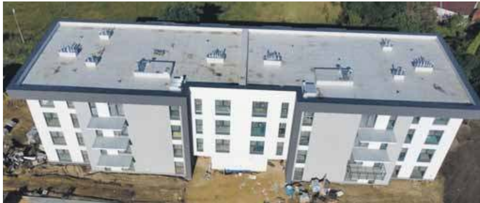
Inwestycja ma być zakończona w przyszłym roku. Budowa mieszkań kosztuje 48 mln zł
