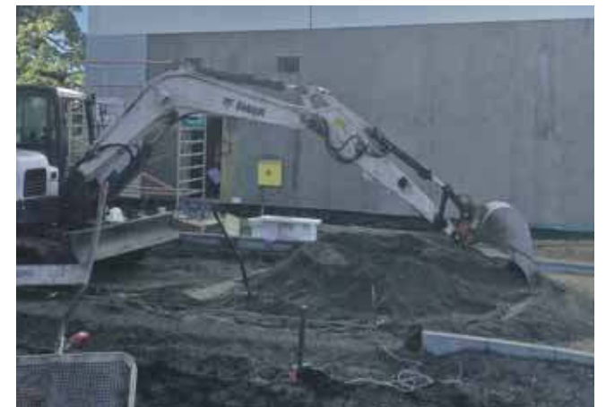
Trwa zagospodarowywanie otoczenia wybudowanej hali
