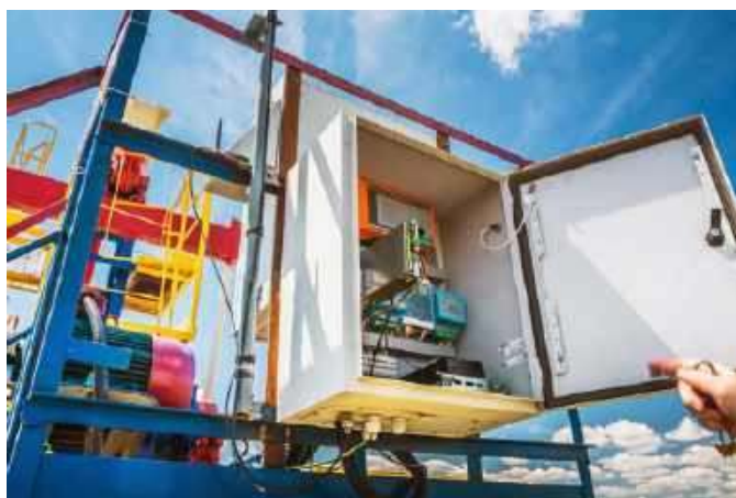
Fotografia 1. Obudowa obiektowa zamontowana na konstrukcji zewnętrznej – przykład aplikacji, w której funkcja bariery środowiskowej dominuje nad pozostałymi
