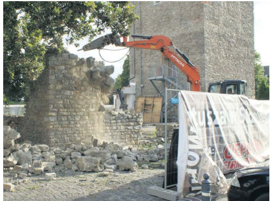
Trwa rozbiórka współczesnych murów, które do tej pory udawały ruinę
