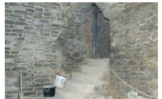
Specyfiką podziemi ratusza jest to, że każde pomieszczenie znajduje się na innym poziomie
