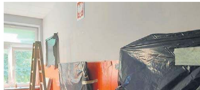
Remont w szkole w Niemysłowie
