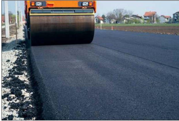
Odcinek S19, o zielone światło na budowę którego ubiega się GDDKiA to 22,3 km między Radzyniem Podlaskim a Międzyrzeczem
