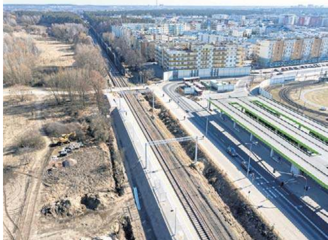
Przystanek kolejowy na Piątkowie. Po północnej stronie (na zdjęciu po lewej) będzie drugi dworzec autobusowy
