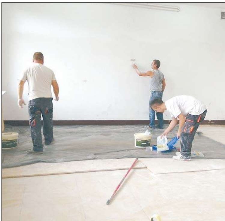
W Zespole Szkół w Żyrakowie trwa przebudowa kuchni.
