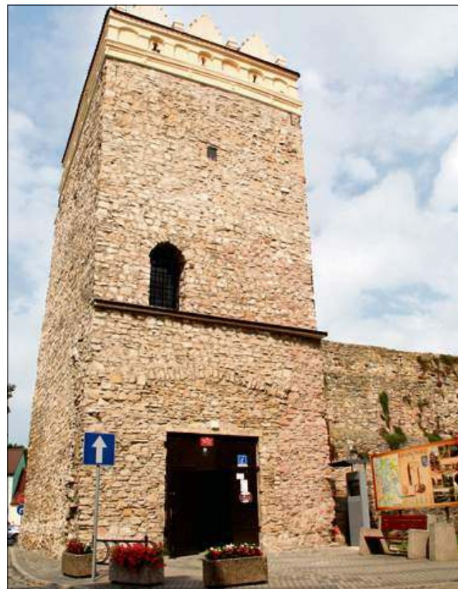
Zostaną wymienione drzwi wejściowe oraz drzwi prowadzące na taras widokowy na szczycie wieży.
