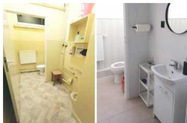
„Przed” i „po” remoncie. Efekt widać gołym okiem
