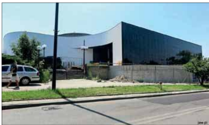
Prace na terenie budowy nie zostały wstrzymane
