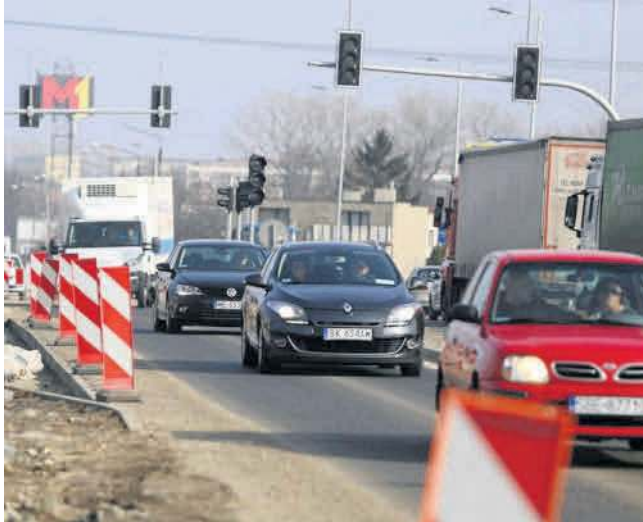
Budowa nowego skrzyżowania na drodze krajowej 94 w Czeladzi ciągnie się od czerwca ubiegłego roku
