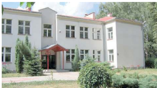
Już niedługo szkoła w Chrzążachowie przejdzie gruntowną termomodernizację. Prace przeprowadzi lubelska firma.
