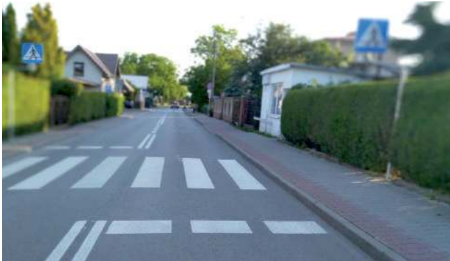
Na ulicy Głowackiego po wykonaniu projektu reorganizacji ruchu pojawiły się m.in. dwa nowe przejścia dla pieszych w centrum i trzecie zlokalizowane przy ulicy Granicznej
