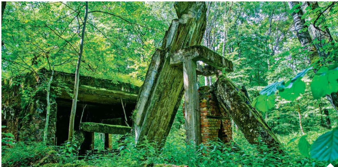
Dzięki pracom leśników wiele obiektów zostało odsłoniętych
